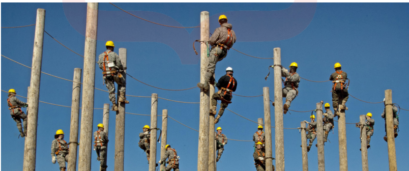
Trabajo en altura
